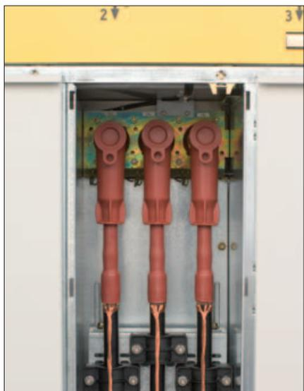
В настоящее время получили большое распространение РУ с газовой изоляцией. Такие РУ имеют очень компактные отсеки для подключения кабелей. Кабельные отсеки закрыты со всех сторон металлическими стенками, а значит, полностью экранированы. Для подключения кабелей применяются специальные адаптеры. Для закрытых кабельных отсеков применение экранированных адаптеров не требуется.
