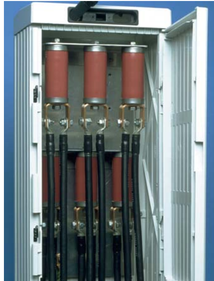
Установка ОПН серии CPA в шкафах для транспозиции экранов высоковольтных кабелей
