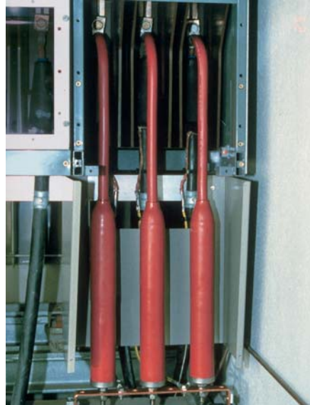
Ячейка РУ с типовым кабельным вводом и ОПН серии SPA-I
