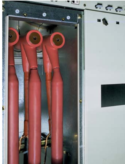
Подключение кабельной линии совместно с ОПН типа RDA с помощью адаптера типа RICS к выключателю с газовой изоляцией.
